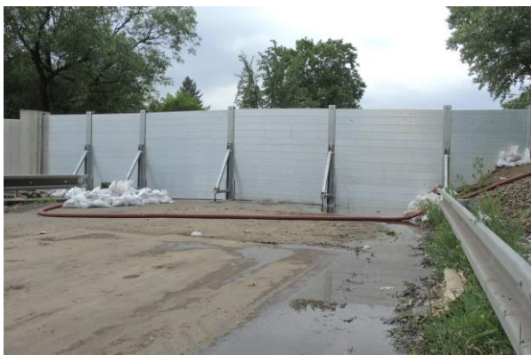
Mobilní protipovodňové zábrany v Lovosicích (vlevo) a Píšťanech při povodni v červnu 2013
