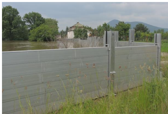
Mobilní protipovodňové zábrany v Lovosicích (vlevo) a Píšťanech při povodni v červnu 2013
